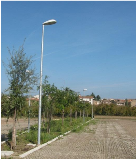
Figura 6.19 - testapalo, ottica con vetro piano vetro piano
